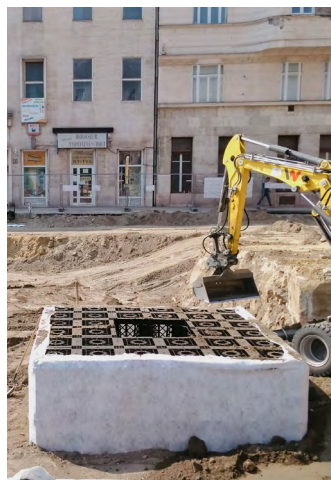
76. fotó: Gyökércellák közepén az ültetőlyukkal 35. ábra: Gyökércellás fahely
