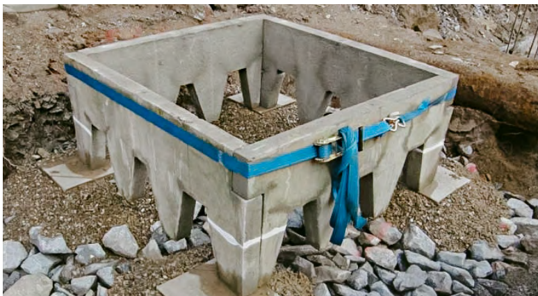
71. fotó: A stockholmi betonszegély kivitelezés közben
