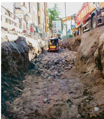
67. fotó: Ültetőárok készítése, Stockholm 68. fotó: Ültetőárok kialakítása meglévő fánál, Stockholm
